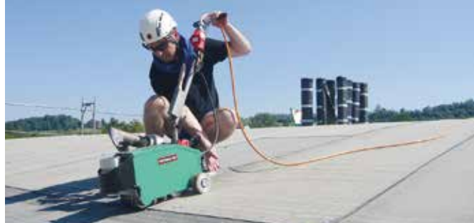
Bezplamenné svařování modifikovaného bitumenu - BITUMAT B2.
