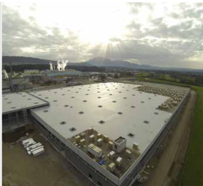
Aldi (logistické centrum, 50000m2 TPO fólie, Švýcarsko)
