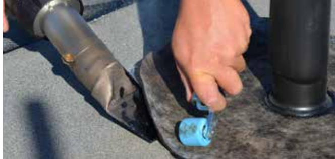
ELECTRON ST svařování bitumenových pásů.
