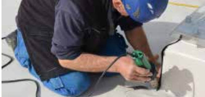
Bodování střešní fólie.
